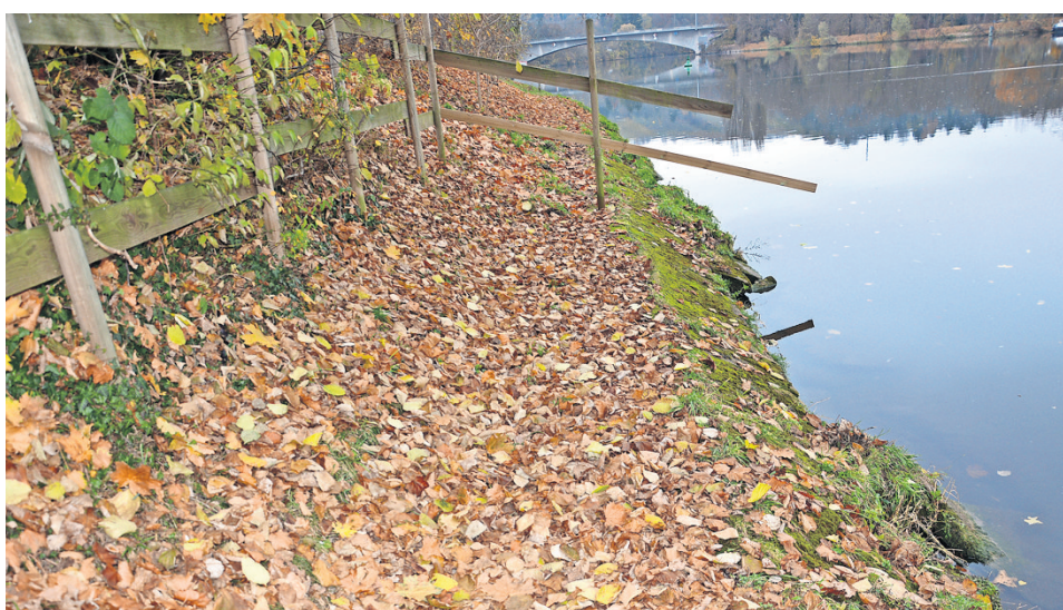
An einigen Stellen ist die glatte Böschung mit Moos bewachsen und daher sehr rutschig.
