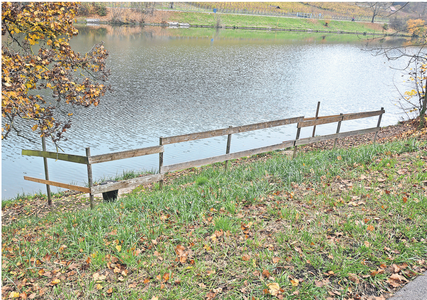
Eine Holzabschrankung soll an verschiedenen Stellen den Zugang zum Ufer verhindern.
